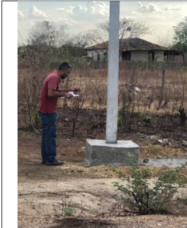
Figura 3.13 - Foto do ponto de apoio R5
