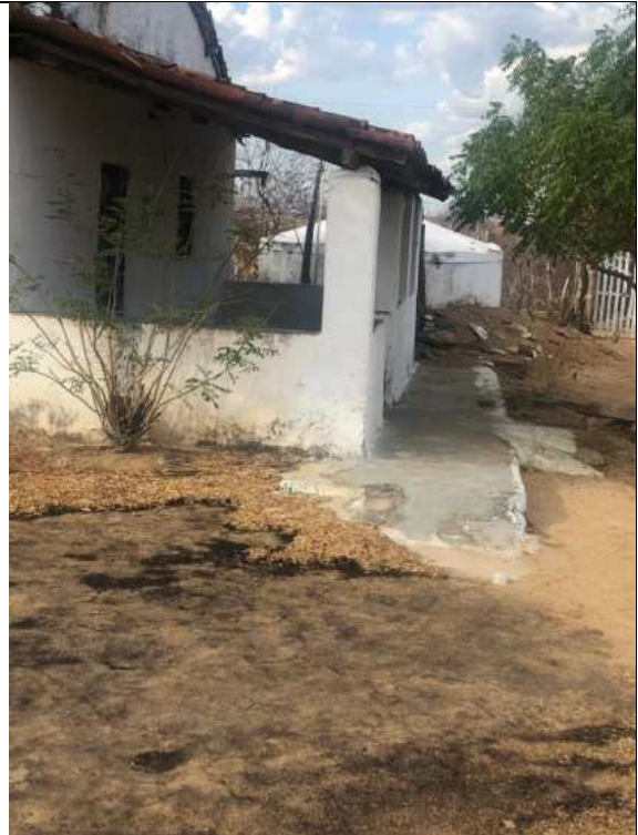
Figura 3.10 - Foto do ponto de apoio R1
