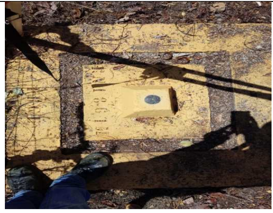
Figura 3.2 - Foto do Marco do IBGE RN1861M
